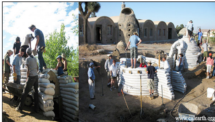
Figura 4: Ejemplos de edificios en ejecución en autoconstrucción. Fuente: Calearth.org. [3]
