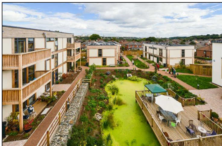
Figura 1: Complejo de edificios residenciales súper-aislados mediante paja. Fuente: Low Impact Living Affordable Community. Modcell Straw Technology [1]
